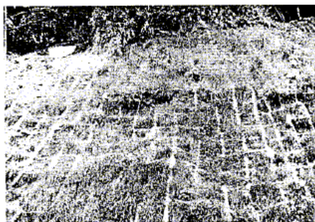
照片七 型框護坡欠缺排水設計導致植栽工程失敗
