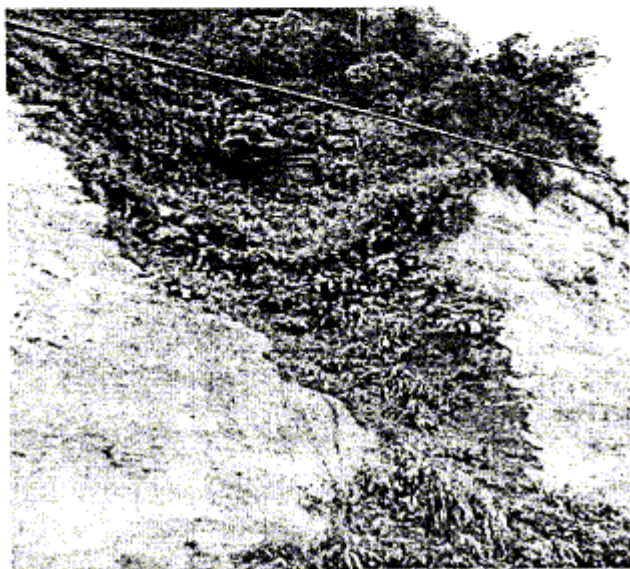
照片六 噴漿工法造成坡面與原植被交界面產生弱面
